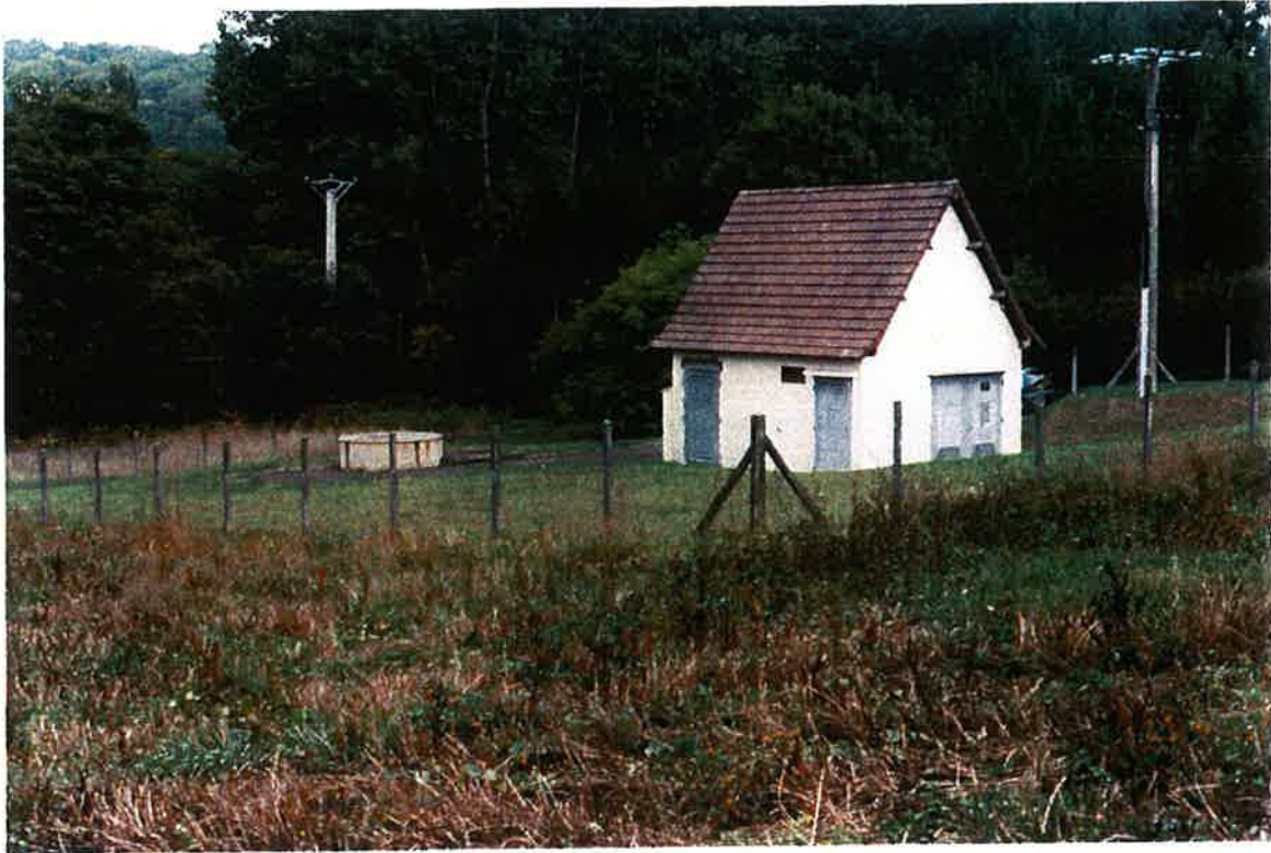
Visualisation du périmètre de protection immédiate du captage Rosay II – Tête du puits
